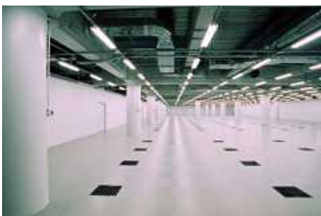
拡張性の高いサーバールーム
